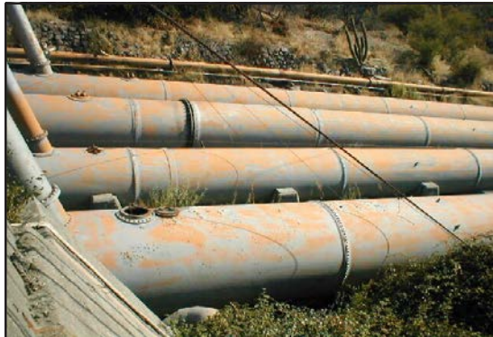
Vista externa de tuberías de carga.
